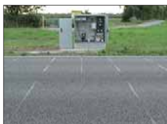
Bild 3: Beispiel einer Dauerzählstelle
